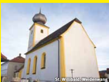
St. Willibald, Weidenwang
