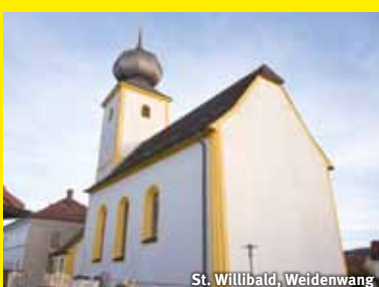
St. Willibald, Weidenwang
