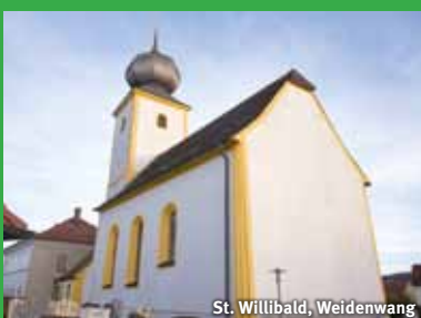
St. Willibald, Weidenwang
