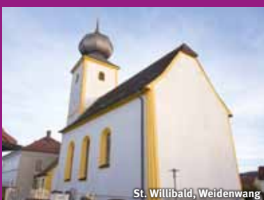
St. Willibald, Weidenwang
