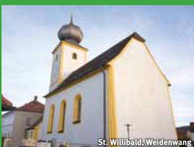
St. Willibald, Weidenwang
