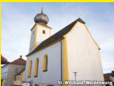
St. Willibald, Weidenwang
