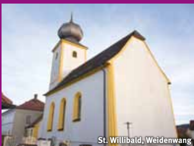
St. Willibald, Weidenwang
